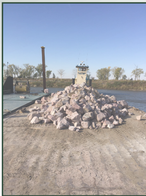
Rip rap ya que se carga en la barcaza.
